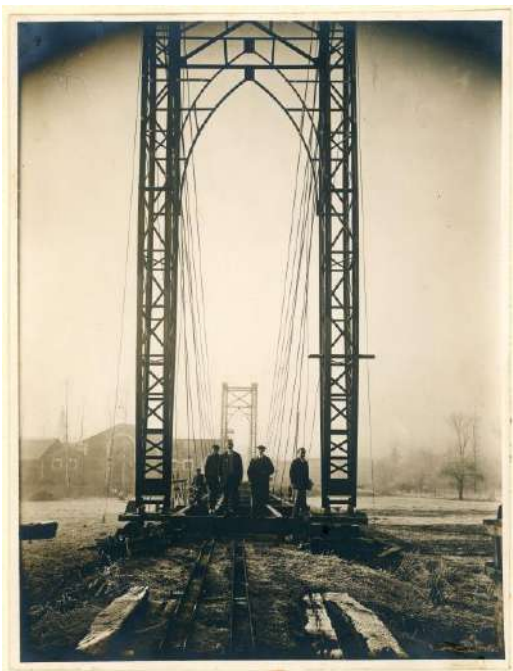
Construction du premier pont Gisclard pour le Siam ? (Chine) dans l'usine de Larche en 1925. Au centre, Gaston Leinekugel Le Cocq. 46 S, fonds Arnodin – Leinekugel Le Cocq, Archives de Brive.
